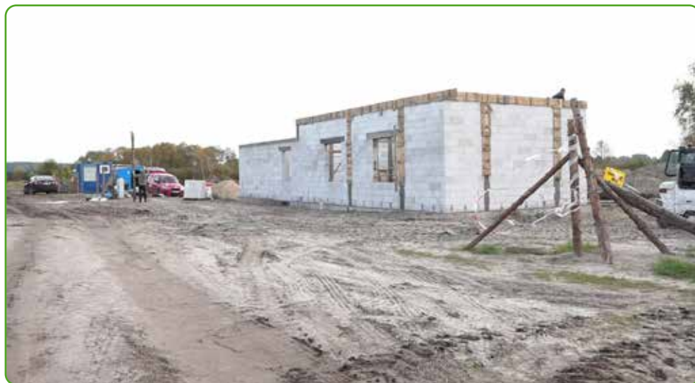
Oczyszczalnia w Jamielniku
