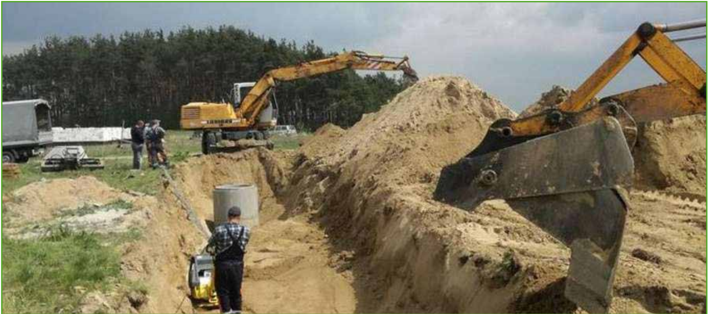
Prawie 3,2 mln zł na kanalizację i wodociągi
