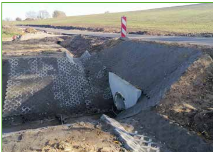
Przepust na drodze Nawra-Mikołajki
