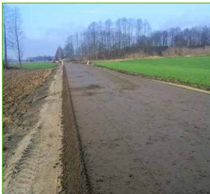
Budowa ul. Polnej w Bratianie
