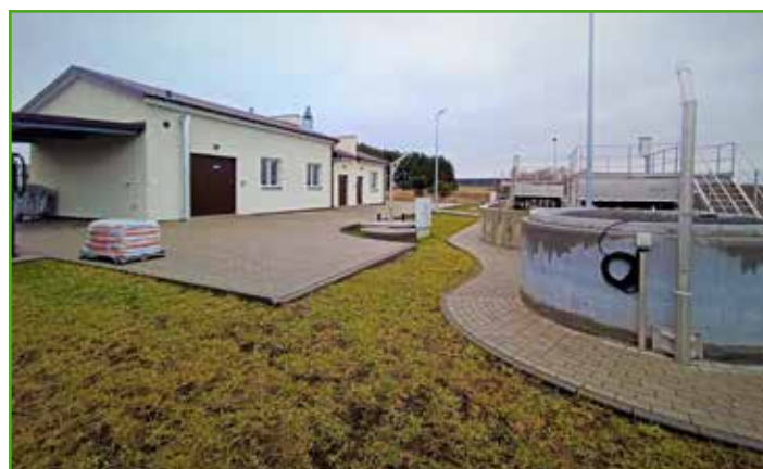
Oczyszczalnia w Jamielniku
