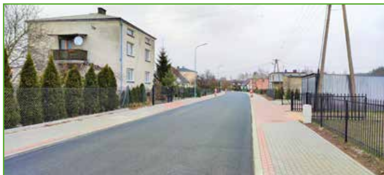
Nowy asfalt ul. Grunwaldzka
