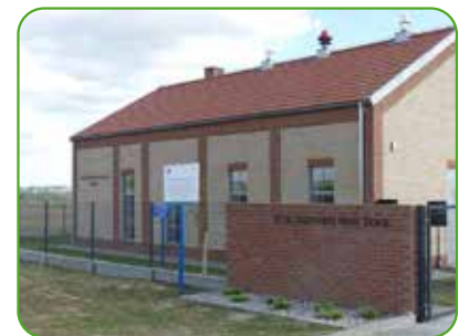
Stacja Uzdatniania Wody
