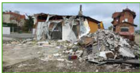
Budynek w trakcie rozbiórki
