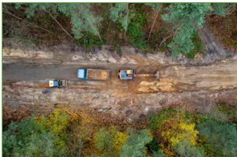
Budowa drogi Mszanowo-obwodnica Nowego Miasta Lubawskiego
